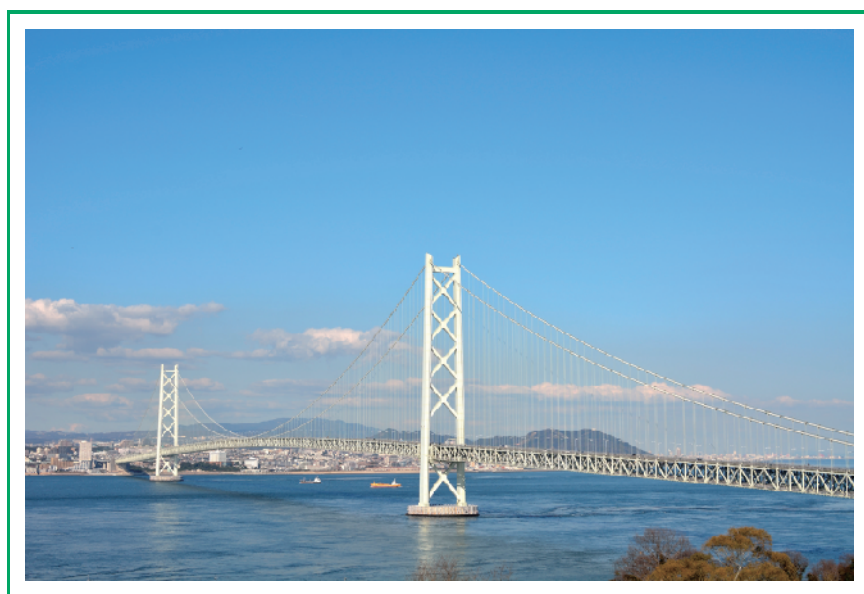
(明石海峡大橋)
