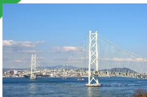
明石海峡大橋
