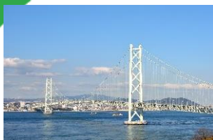
明石海峡大橋
